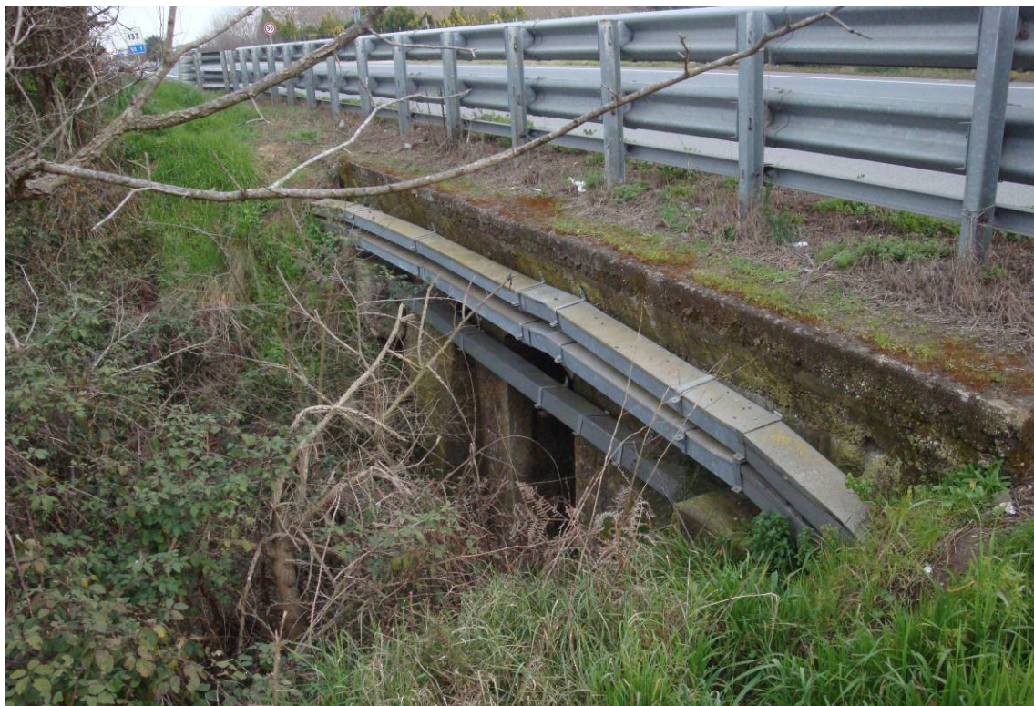
Foto 1 – Vista laterale – struttura originaria: volta in muratura
