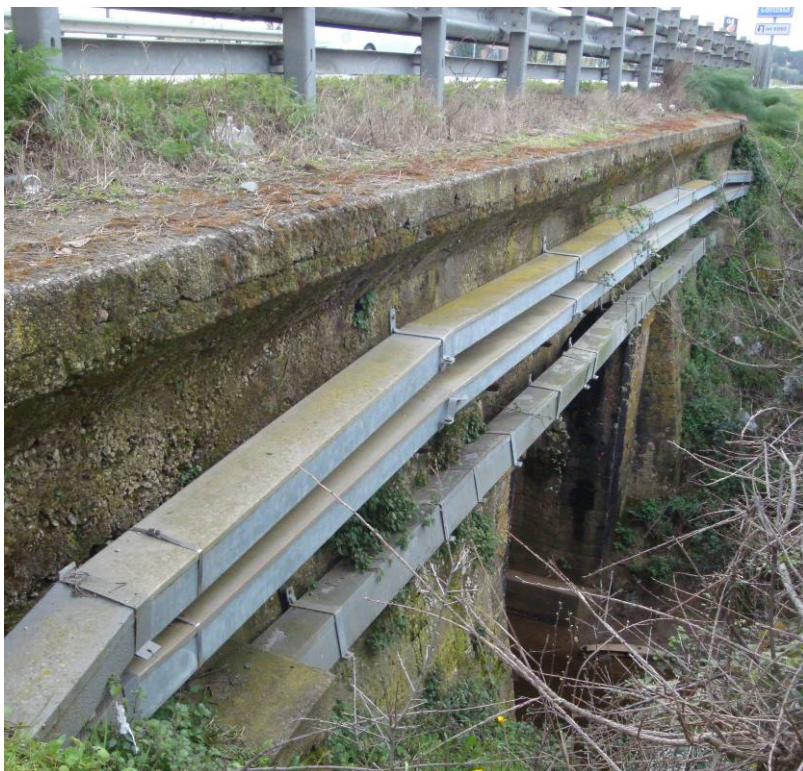
Foto 1 – Vista laterale – struttura originaria: volta in muratura
