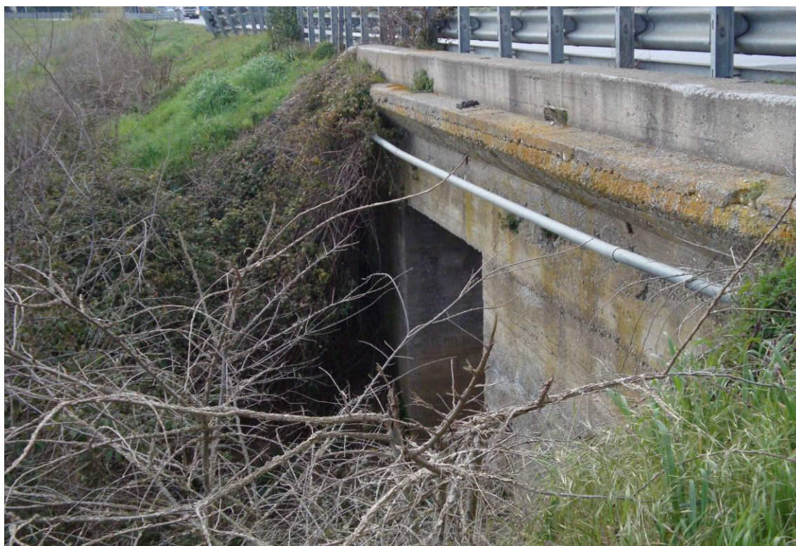
Foto 2 – Vista laterale – struttura in allargamento: scatolare in c.a.
